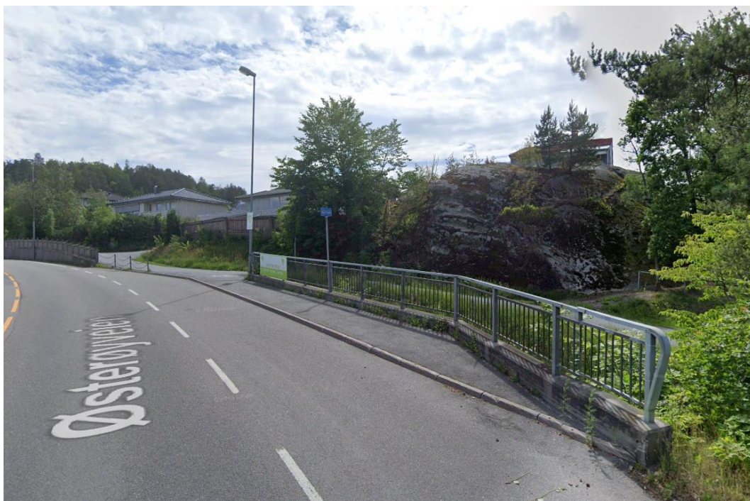
Figur 5-3. Avlämningsficka vid Gokstad skole. Bildkälla: Google Street view.
