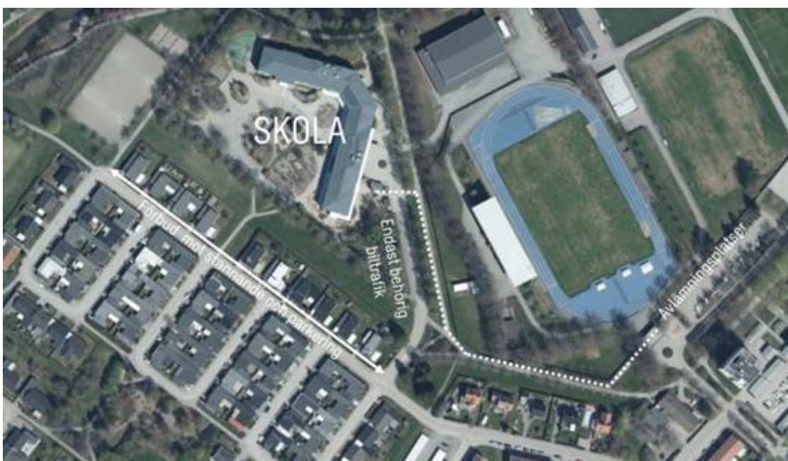
Munksundsskolan. Nuläge. Bildkälla: Lantmäteriet. Redigerad av Sweco/AFRY.
